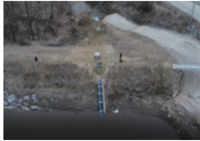
사이펀 취수시설 시공 완료
