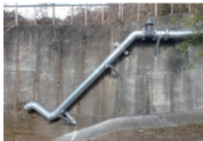
그림 7. 아곡저수지 사이펀 비상방류시설 설치 사례
