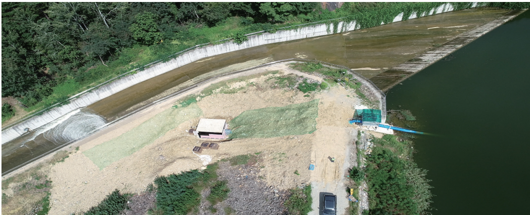
그림 6. 왕암저수지 사이펀 비상방류시설 설치 사례
